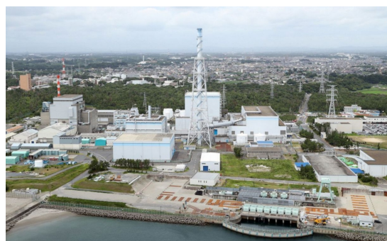
防潮堤の施工不良を修復できない東海第二原発
