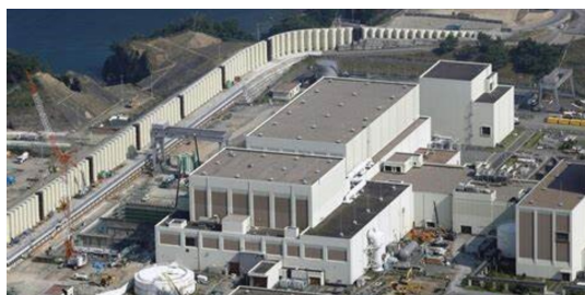
9月再稼働予定の 女川原発2号機
