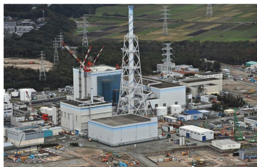
安全対策工事中の東海第二原発
