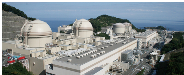
左から大飯原発4号機と3号機。3号機は配管に損傷が見つかり、稼働延期に。
